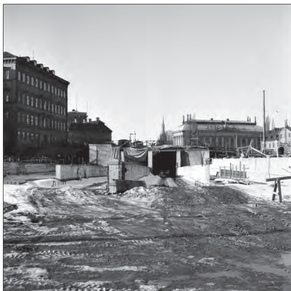
Fig. 43. Foto vintern 1951/52 visar hur Tunnelbanan håller på att byggas. Omfattande mängder utfyllnader och virke från gjutformar och pontoner m.m. från nämnda arbeten har deponerats på botten. Foto: Spårvägmuseet.
