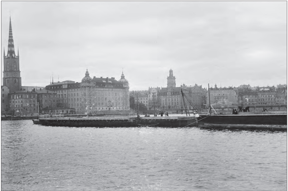
Fig. 41. I "Underrättelser för Sjöfaranden" från 1944 står: "Vid Söder Mälarstrand, kajplats 10, kommer fr.o.m. den 29 september och tills vidare att utläggas en pir för tippning av sprängsten i Riddarfjärden. Piren består av två hopkopplade, förankrade fartygsskrov. Dess längd från kajen är 130 meter, bredden 14 meter. Piren har under mörker vanlig kajbelysning". Ett av dessa fartygsskrov, en pråm med 51 meters längd och 14 meters bredd, sprang läck och sjönk. Pråmen återfanns på 20 meters djup och är nu, liksom sprängstenen, ett minne från dessa arbeten. Foto: Erik Holmkvist/Statens maritima museer.
