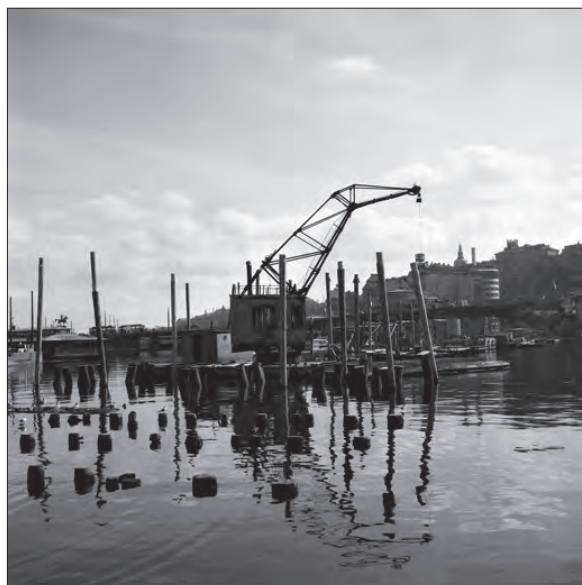
Fig. 44. Pålningensarbeten i samband med nybyggnad av Centralbron på 1950-talet. Centralbron följer samma sträckning som gamla Sammanbindningsbanan. Sammanbindningsbanans pålar syns kapade i förgrunden. Arbetena från det nya brobygget syns också på botten idag. Foto: Spårvägmuseet.
