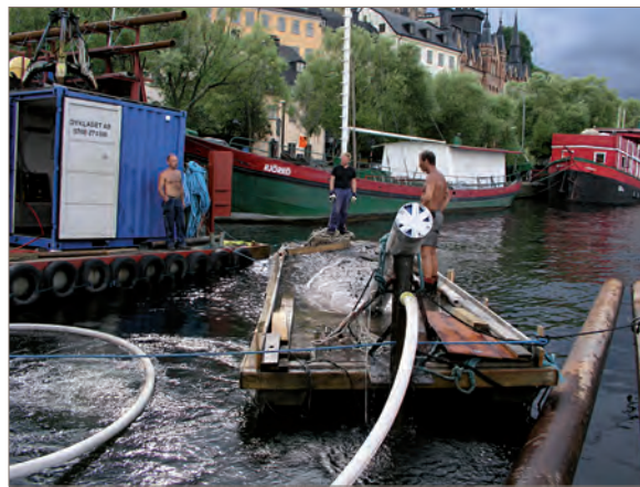
Fig. 80. Tisdagen den 22 augusti. Sugmuddring påbörjad, enligt plan. När det sentida materialet är bortmuddrat kommer ett klenare sugmunstycke kopplas till ett såll för arkeologisk utgrävning av fartygslämningen. Nu, vid den inledande sugmuddringen, lämnas en buffert av sentida material ovanför fartygslämningen. Massorna som kommer upp på pontonen består framför allt av slagg från ångpannor som förmodligen rakats ut vid kajen. Varvat med kol och slagg kommer mycket tegel och ölf flaskor från de senaste hundra åren. Foto: Marcus Hjulhammar/Statens maritima museer.
