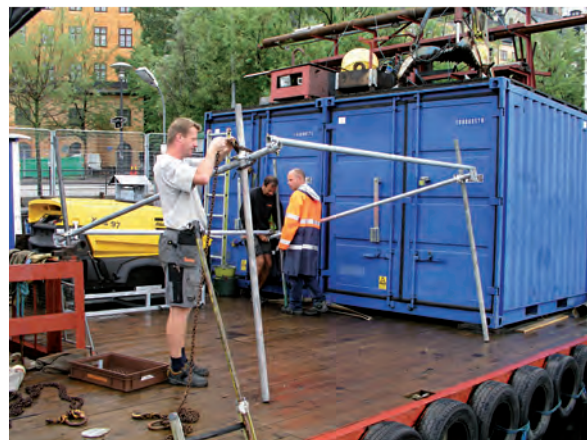
Fig. 78. En ställning byggs för att skydda de synliga delarna av fartygslämningen vid sugmuddring av grövre material. Det grövre materialet som ska tas bort utgår från de synliga delarna av fartygslämningen och söderut mot kajen. Fartygslämningen ligger i botten av en brant slänt. Foto: Marcus Hjulhammar/Statens maritima museer.
