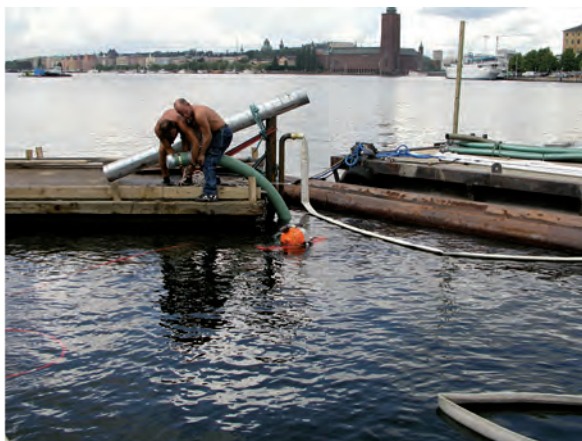
Fig. 79. Utrustning på plats för inledande sugmuddring. Dykare i vattenytan tar emot sugslangen för montering under vattnet. Foto: Marcus Hjulhammar/Statens maritima museer.
