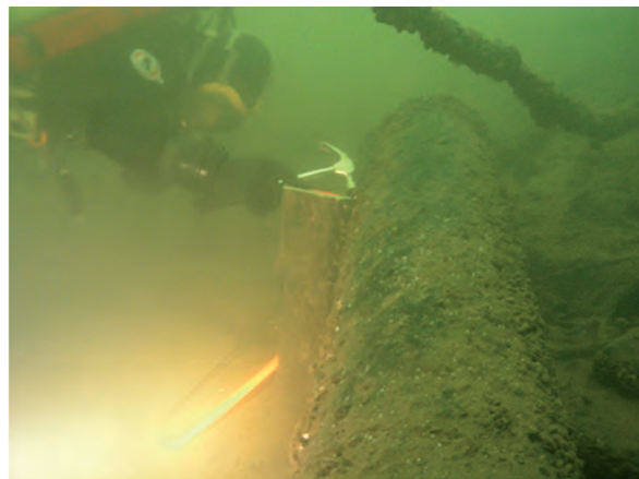
Fig. 72. Dykare spikar fast en märkbricka på den nyligen avsågade pålen utanför Riddarholmen. Foto: Marcus Hjulhammar/Statens maritima museer.
