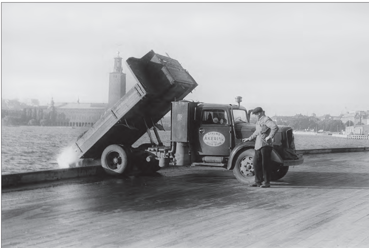
Fig. 40. Tipping av sprängsten från lastbil i östra Riddarfjärden hösten 1944. Piren är en pråm som var förankrad utanför kajplats 10 vid Söder Mälarstrand. Foto: Erik Holmkvist/Statens maritima museer.
