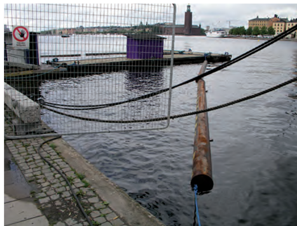
Fig. 75. Stängslet på plats och pontonerna stadigt förankrade med hjälp av Stockholms Hamnentreprenad. Pontonerna bildar en lagun inom vilken fartygslämningen ligger. Ur dykerisäkerhetssynpunkt blir det en väl avgränsad arbetsplats mot den trafikerade farleden till och från Karl Johanslussen. Foto: Marcus Hjulhammar/Statens maritima museer.
