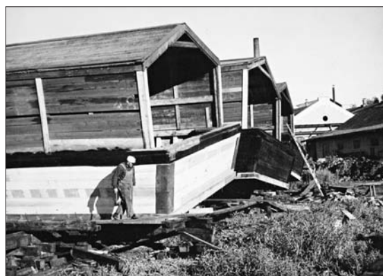
Fig. 4. Övre bilden visar ytterhörnorna, i nedre kanten på bilden syns plåten. Bilden längst ned till vänster visar en av "slasarna" som går ner i pråmen. Bilden till höger visar Karl Berglund som spikar på hörnplåtar på en ny eller nyrenoverad pråm. Notera de äldre pråmarna i bakgrunden som renoverats.
