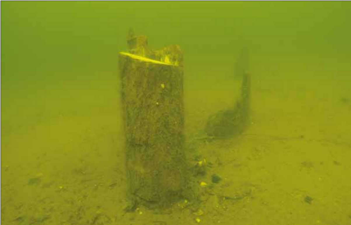
Fig. 7. Raä 113/ Id 14, pålar till trolig dykdalb. På pålen i förgrunden har ett träprov tagits. Foto: Patrik Höglund, Sjöhistoriska museet.
