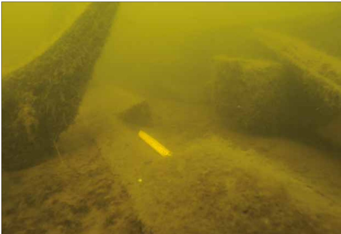
Fig. 4. Nedre delen av pråmroten till vänster. I nederdelen syns det längskeppsgående timret med urtag för bottenstocken till höger. Foto: Patrik Höglund, Sjöhistoriska museet.
