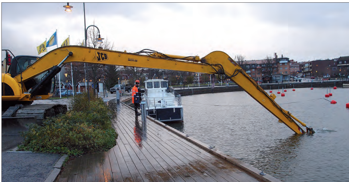
Fig. 2. Grävmaskin gräver testschakt. Foto: Gustav Bergljung, Sjöhistoriska museet.
