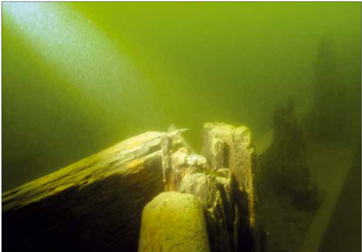
Fig. 14. Id 18. Notera de kraftigt eroderade pråmrötterna samt förstärkningen som syns närmast i nederkant på bilden. Foto: Jim Hansson, Sjöhistoriska museet.
