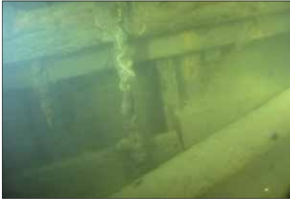
Fig. 15. Id 18. Den övre inre plankan samt den underliggande förstärkande plankan. Notera även de förstärkande spanten innanför dessa. Foto: Patrik Höglund, Sjöhistoriska museet.
