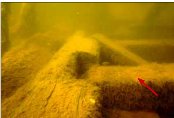
Fig. 20. Id 28. En yttre balk med urtag för en bottenstock. Notera även det rostiga spåret (röd pil) efter en järnbult som har förankrat en av pråmrötterna på en bottenstock. Foto: Jim Hansson, Sjöhistoriska museet.
