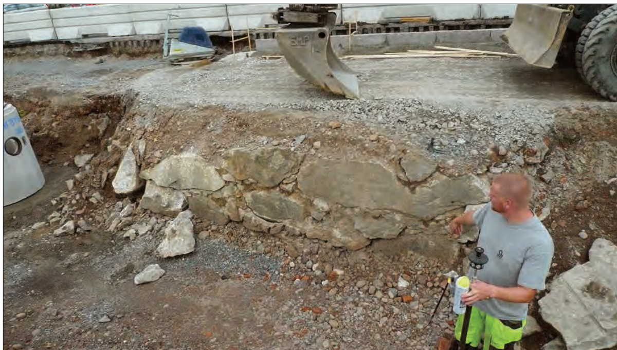
Figur 14. Kvarvarande del av den kallmurade kajskoningen efter schaktningarna. Foto Jim Hansson, Sjöhistoriska museet.
