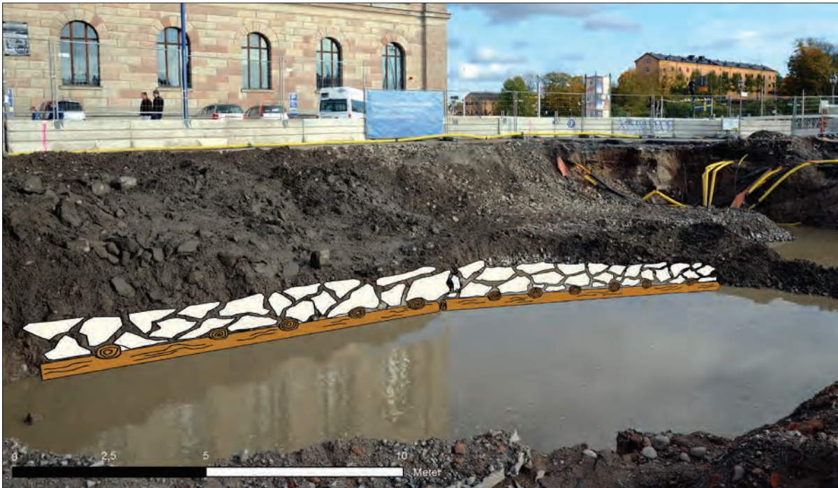
Figur 11. Vattenfylldt schakt utanför Nationalmuseum med en grov rekonstruktion av det som tolkats som en ramp. Bild och rekonstruktion: Jim Hansson, Sjöhistoriska museet.
