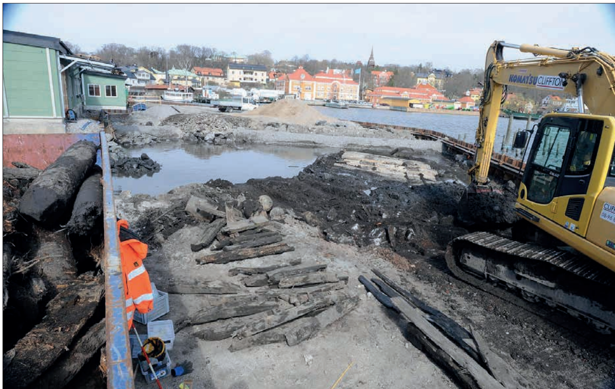
Fig. 6. Översiktsbild över "område" 1 (vattenfyllda gropen och ut till pontonen) vy mot norr med upptagna vrakdelar för dokumentation. Foto: Patrik Höglund, Sjöhistoriska museet.
