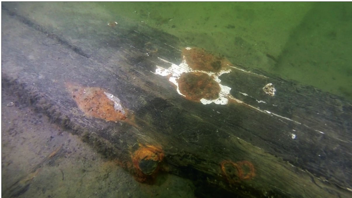
Fig. 16. Bilden visar en del av den förmodade akterspegeln. De röda fläckarna visar korroderat järn och de vita områdena är förmodligen färgrester. Foto: Jens Lindström/Sjöhistoriska museet.
