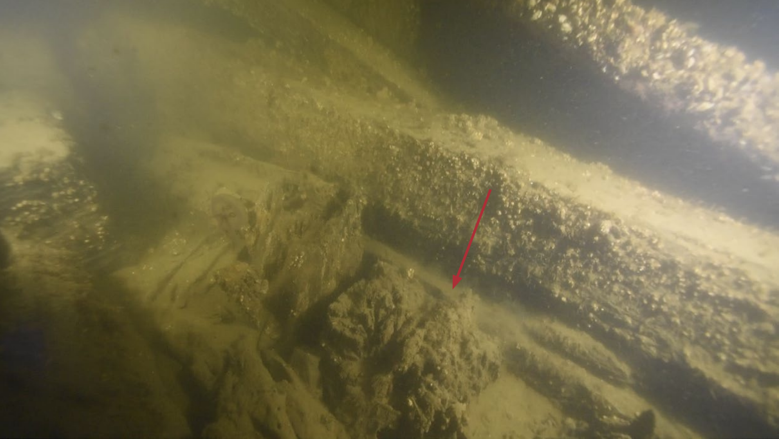
Figur 21. Flera kraftigt eroderade spant visar att skeppet var i dåligt skick och troligen bedömdes som utjänt då det hamnade på botten. Foto: Jim Hansson, Statens maritima museer.
