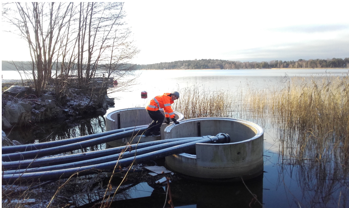
FIGUR 7. FNordväst om ångbåtsbryggan har cementrör lagts ner och en ledningsdragning förberetts. Det verkar vara muddrat från land ut mot bryggan. Bro 313 (ID 7) bör ligga till höger i bild vid vasskanten. Cementrören har inte att göra med KF Fastigheters utvecklingsprojekt (Andersson 2019). Foto: Mikael Fredholm, Statens maritima och transporthistoriska museer
