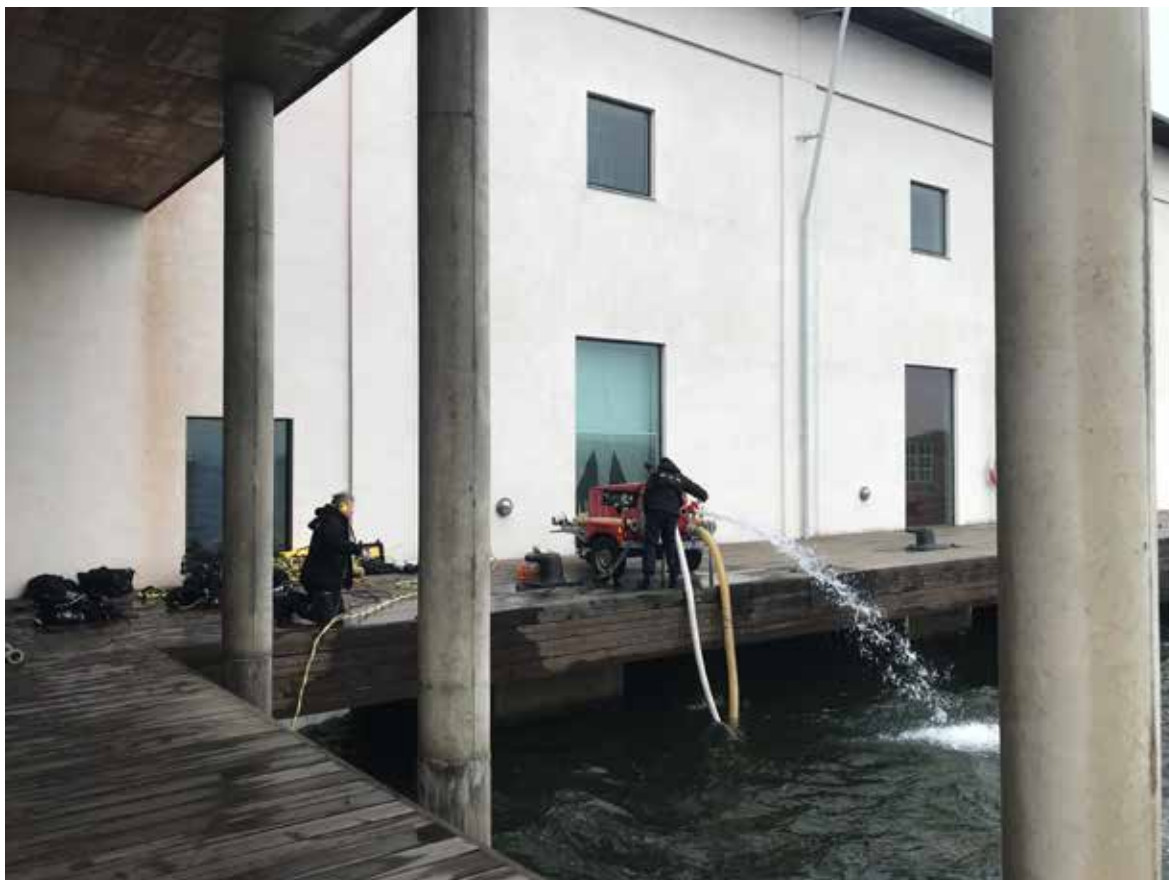
FIGUR 12. Bilden visar dykplatsen med den stora brandpumpen uppställd. Dykarna fick simma till vänster i bild in under museet med slangar genom ett litet hål i den presenning som finns uppsatt runt vraket och därefter in mot vrakplatsen. Foto: Jim Hansson, Statens maritima och transporthistoriska museer.
