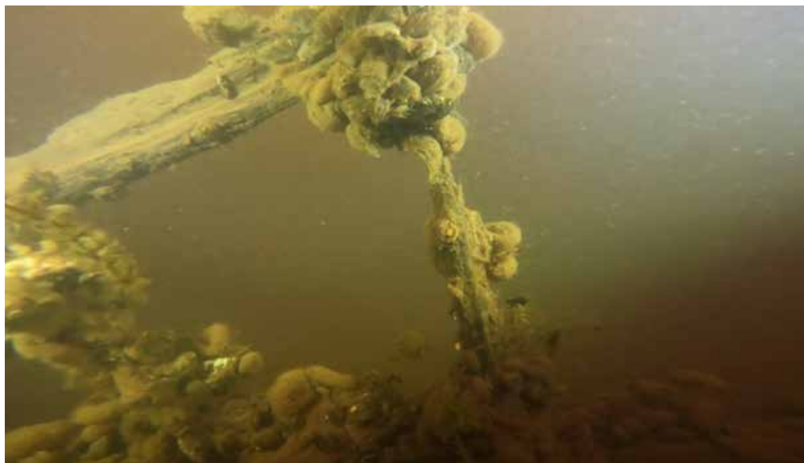
FIG. 6. En kopparnit syns tydligt i det anfrädda spantet. Foto: Mikael Fredholm, SMTM.
