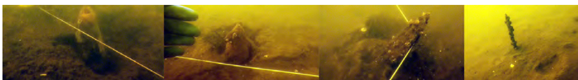
FIGUR 12. Ett kollage av olika påltyper i spärranordningen L2019:452. Pålen längst till vänster är prov 1. Det man ser av pålarna är att de varierar i karaktär, runda i furu (1-2 från vänster), mer trekantiga/radialspräckta i ek och smala och eroderade spetsiga, som längst till höger. Foto: Mikael Fredholm, SMTM. (Digitalt museum: Fo223585).
