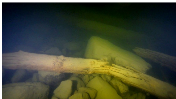
FIGUR 33. Stocken som sannolikt varit en del av den kraftiga stenkistan är splittrad i den vänstra delen samt på mitten. Möjligen är det en explosion som orsakat detta.
