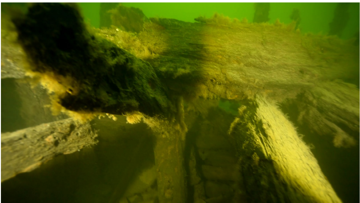
FIGUR 35. Den skuggade skeppsdelen är ett bevarat knä som använts för att stärka däcksbalkskonstruktionen. Knät sitter fortfarande på sin plats på insidan av styrbordssidan. Vinklarna på dessa knän avslöjar en hel del om skrovets form samt var dom suttit i skrovet. Foto: Jim Hansson, SMTM. Digitalt museum: Fo223565.
