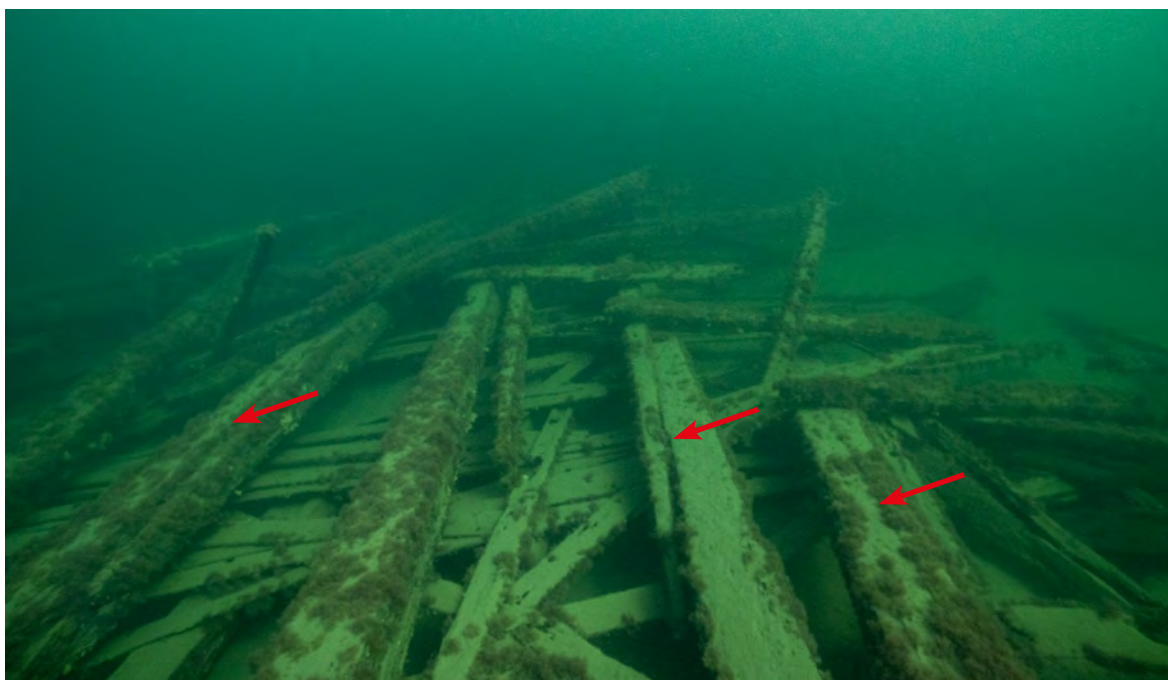
FIGUR 42. Balkarna ligger tvärs vraket och försvinner ofta ner i sedimenten på styrbordssidan. På bilden syns tre av balkarna som är skarvade mitt på, se röda pilar. Foto: Jim Hansson, SMTM. Digitalt museum: Fo223655.
