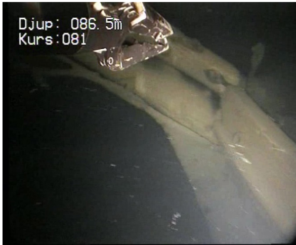
FIG. 2 Förstäven och bogsprötet fotat från babordssidan. Foto: Kustbevakningen, 2024-08-04.
