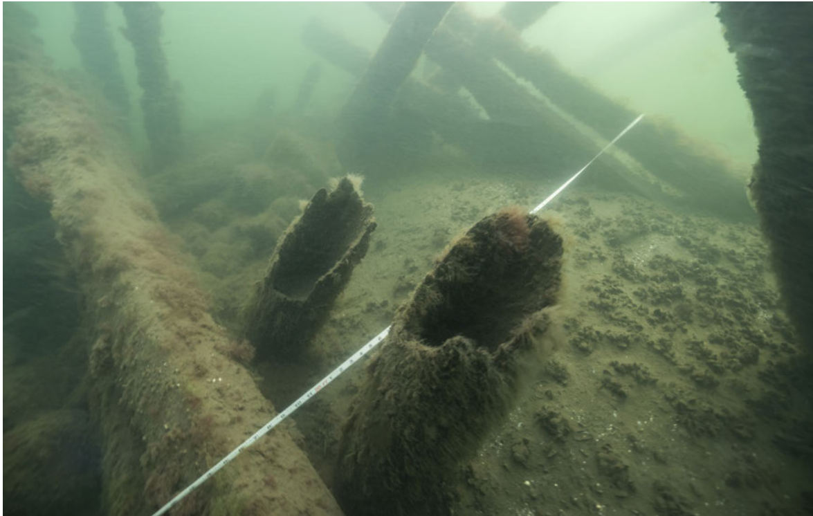
FIGUR 7. Pumparna står i sitt ursprungliga läge precis för om en däcksbalk.
