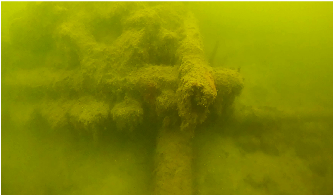
FIGUR 26. Stenkista 6. Här syns tydligt att stenkistan är försedd med timrad botten. Foto: Mikael Fredholm, SMMTF. (Digitalt museum: VK. V 0451).
